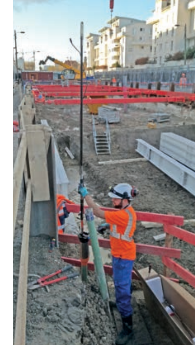
Instalación de la cadena de BH-Profile
