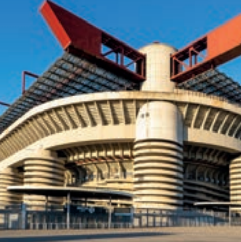
Monitorización dinámica de la cubierta mediante inclinómetros Estado de San Siro, Milán - Italia
