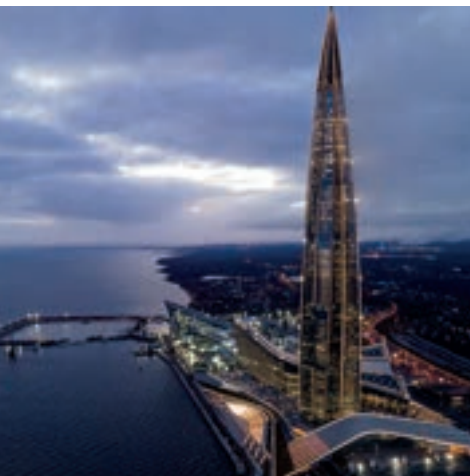
Cimentación y monitoreo de edificios Torre Lakhta, San Petersburgo - Rusia
