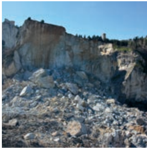
Deslizamientos de Maratea, Italia
