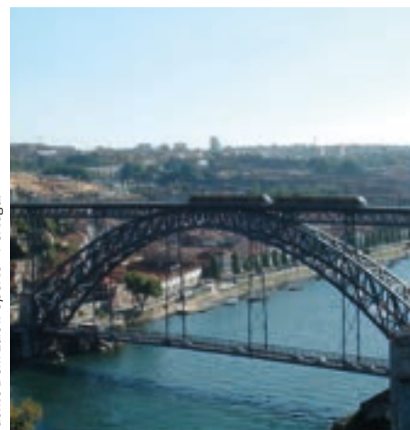
Puente Dom Luís I, Oporto - Portugal
